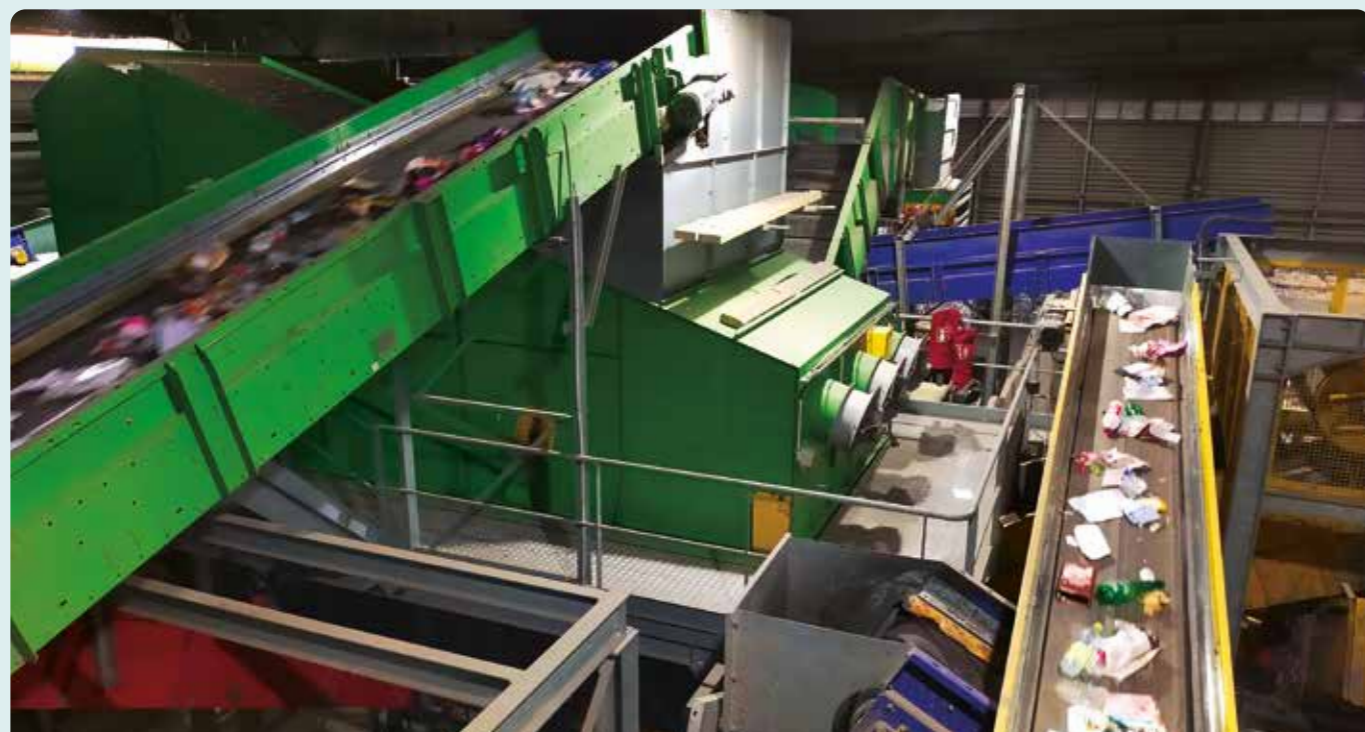
Les tapis de tri du centre de tri Natriel à Dreux (Eure-et-Loir).
