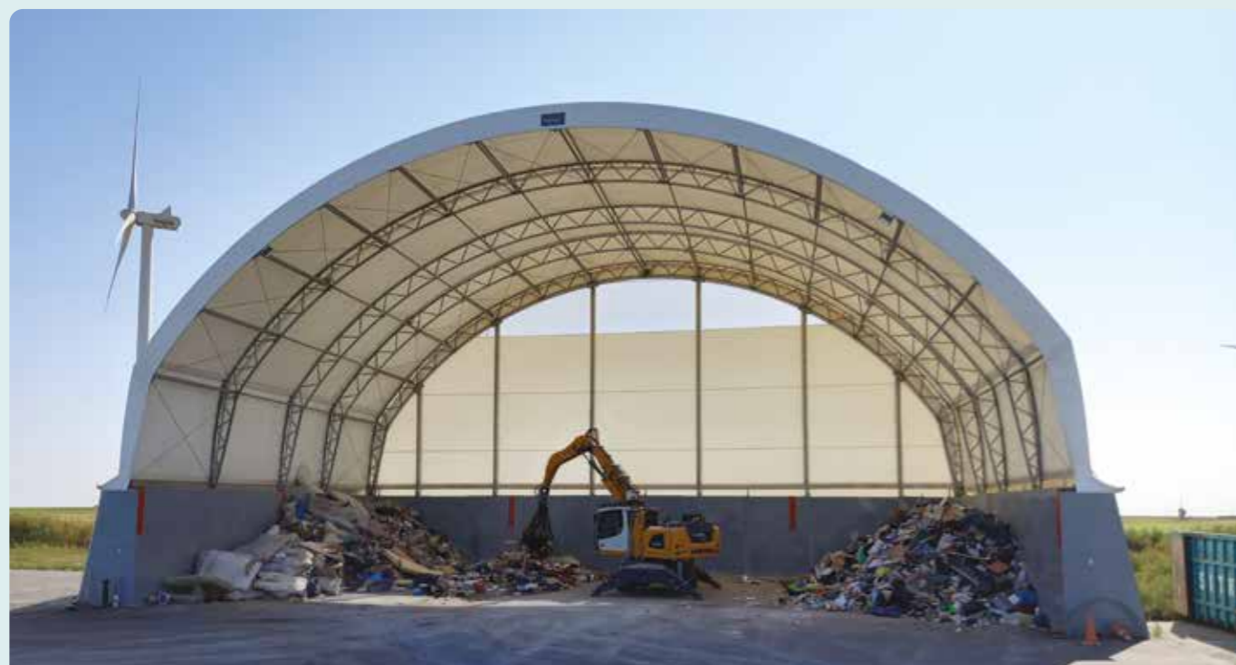
Le dôme nouvellement installé au centre de transfert de Ouarville (Eure-et-Loir) protège le voisinage des nuisances occasionnées par le tri du tout-venant.
