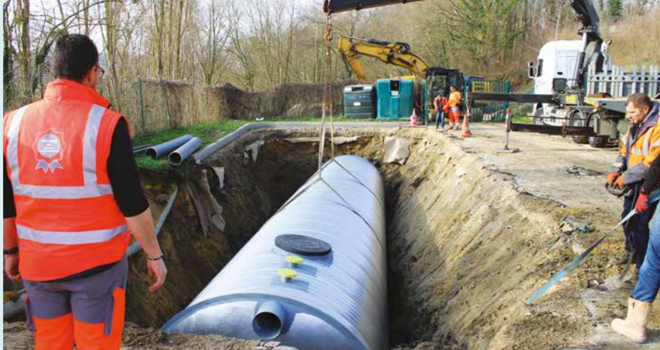
Installation d'une citerne enterrée à la déchèterie de Saint-Chéron (Essonne).
