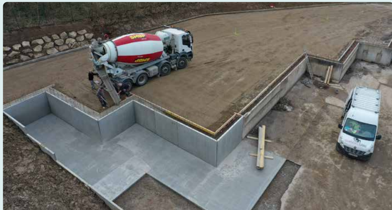
Travaux d'extension des quais de la déchèterie de Bû (Eure-et-Loir).
