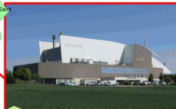
Usine d'Incinération des Ordures Ménagères
