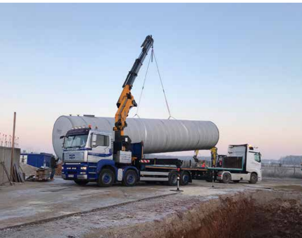
mise en place d'une citerne de rétention - déchèterie de Pierres
