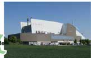
CENTRE DE VALORISATION ÉNERGÉTIQUE
