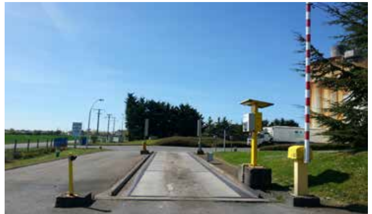
Quai de Châteaudun (28)
