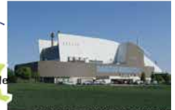
CENTRE DE VALORISATION ÉNERGÉTIQUE
