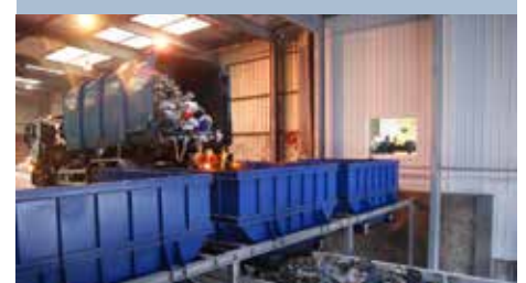
Centre de transfert - Châteaudun
