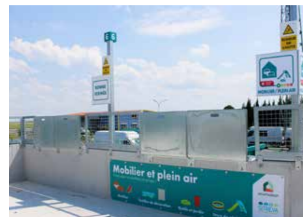
Déchèterie d'Angerville - les quais de déchargement ont été sécurisés.
